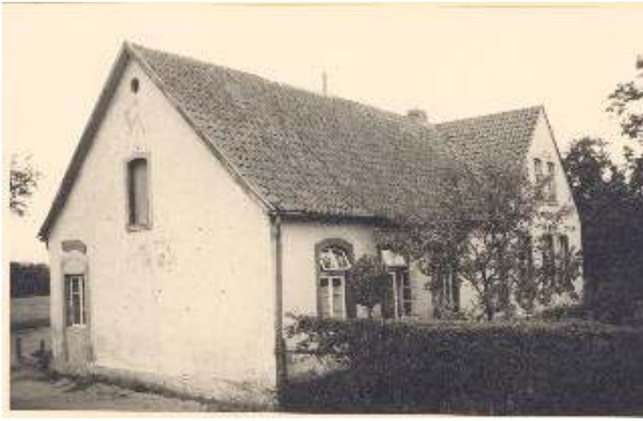
Foto: Die 1854 errichtete Schule in Hörne-im 1892 gebauten Querbau die Lehrerdienstwohnung
