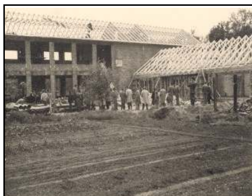
Richtfest am 08. Mai 1961
