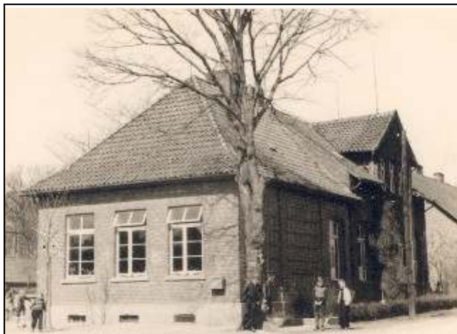
Foto von 1949: 3. Schulhaus - erbaut 1900/1901
